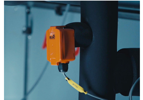
Belimo-sensoren zorgen voor een behoefteregeld gebruik van verwarmings- en koelingsinstallaties.
