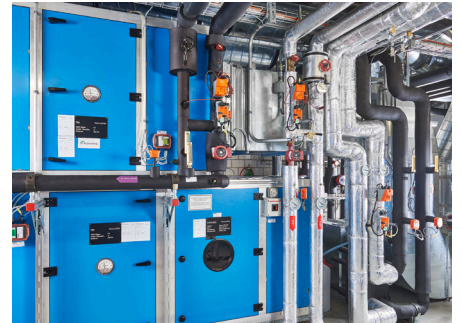
Mesure et régulation en un seul appareil – les Belimo Energy Valves réalisent les deux fonctions.
