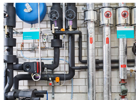
Des capteurs de température de Belimo pour la mesure précise de la température de l'eau
