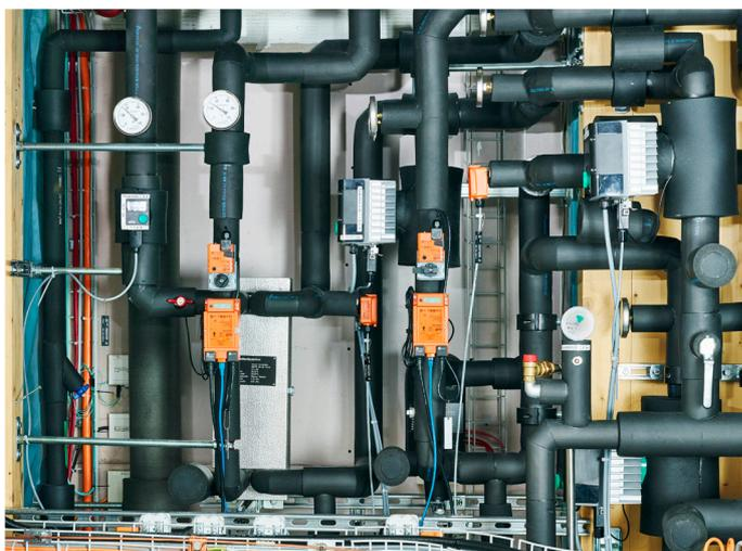
Belimo Energy Valves der neuesten Generation sorgen für die Messung, Regelung und Abrechnung der Heiz- und Kühlenergie.
