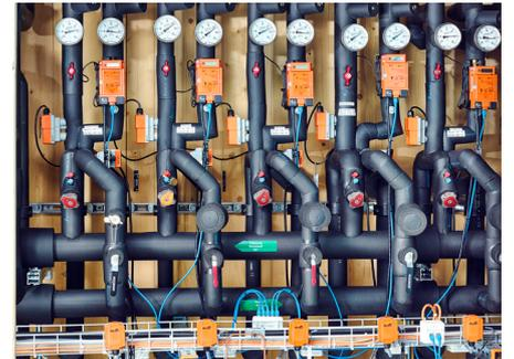
Thermische Energiezähler ermöglichen, dass die verbrauchte Energie je Zone separat abgerechnet werden kann.
