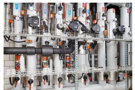
Heizverteilung mit elektronisch druckunabhängigen Ventilen (EPIV), Temperatursensoren und Temperaturwächter
