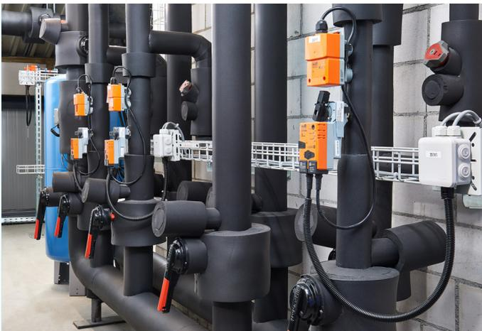
Kälteverteilung mit elektronisch druckunabhängigen Ventilen (EPIV).
