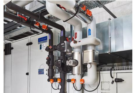
Kreisläufe für die Heiz-/Kühlregister der Lüftung mit elektronisch druckunabhängigen Ventilen (EPIV) und Temperatursensoren.
