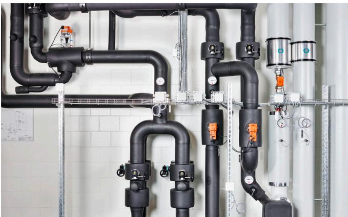
Wie hier bei der Rückgewinnung der Prozesswärme wurden die Belimo-Feldgeräte für diverse Funktionen im ganzen Gebäude eingesetzt.
