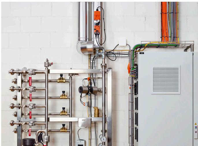
Die druckunabhängigen Regelorgane lassen Anpassungen und Erweiterungen ohne Einfluss auf die bestehenden Anlagen zu.
