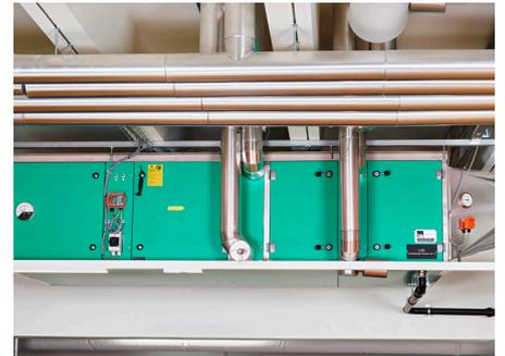
Die Belimo-Feldgeräte wurden in die Anlagen integriert. Sie überwachen und steuern die aktuellen Zustände und alarmieren bei Überschreiten der Grenzwerte.
