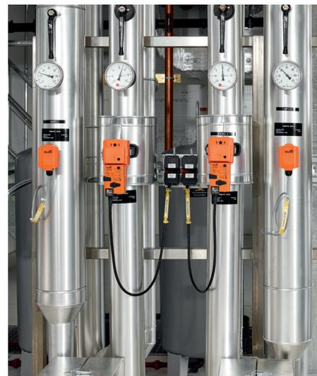
Das USZ verfügt über eine eigene Dampfaufbereitungsanlage, um die korrekte Luftfeuchtigkeit im ganzen Trakt, aber besonders bei Brandverletzten, kontinuierlich zu gewährleisten
