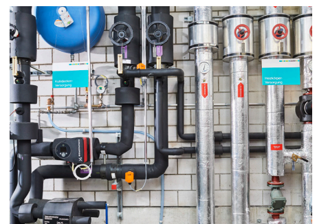
Temperatursensoren von Belimo für die präzise Messung der Wassertemperatur
